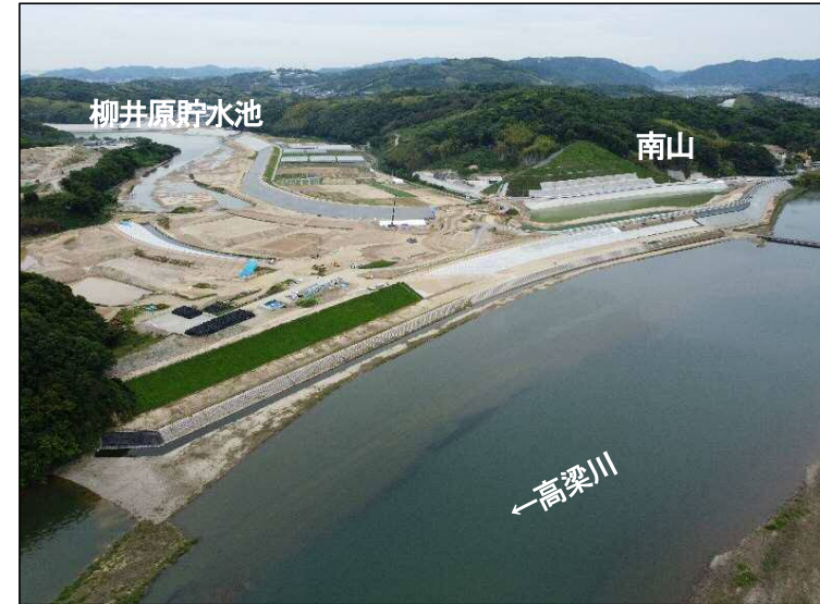
①締切区間(下流より望む)
