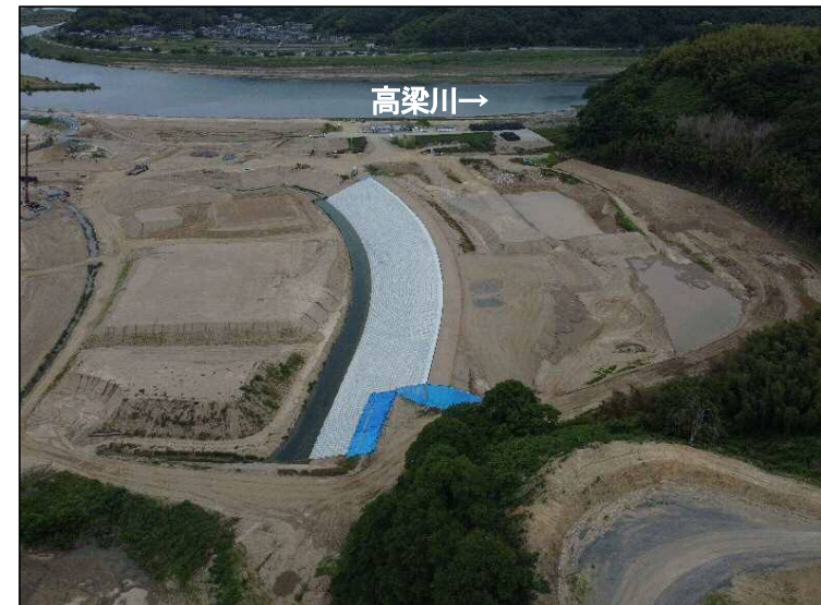
③掘削区間(下流より望む)
