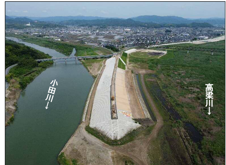
③締切区間(下流より望む)
