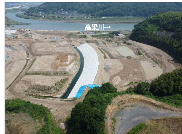
③掘削区間(下流より望む)
