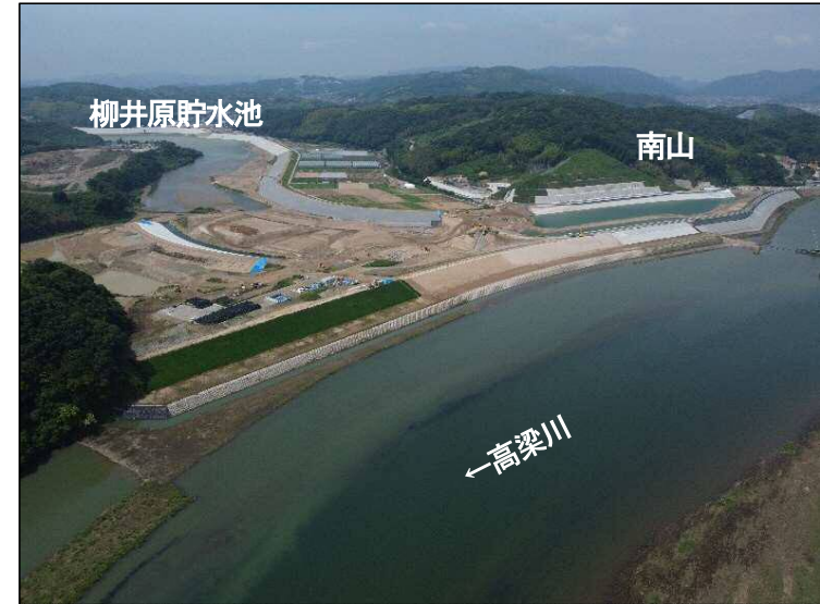
①締切区間(下流より望む)
