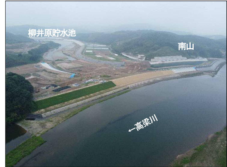
①締切区間(下流より望む)
