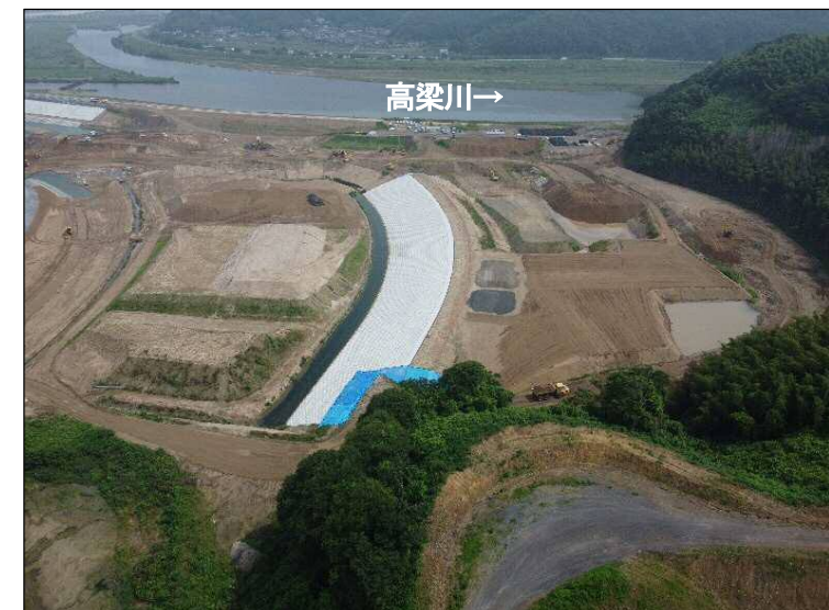
③掘削区間(下流より望む)
