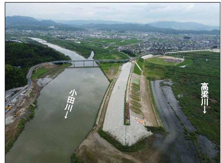
③締切区間(下流より望む)
