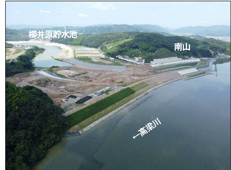
①締切区間(下流より望む)
