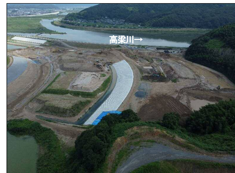
③掘削区間(下流より望む)
