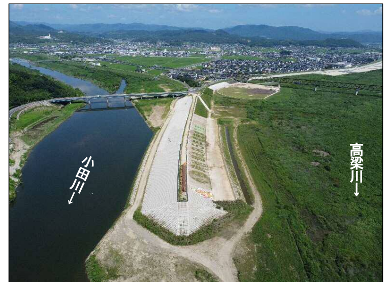
③締切区間(下流より望む)
