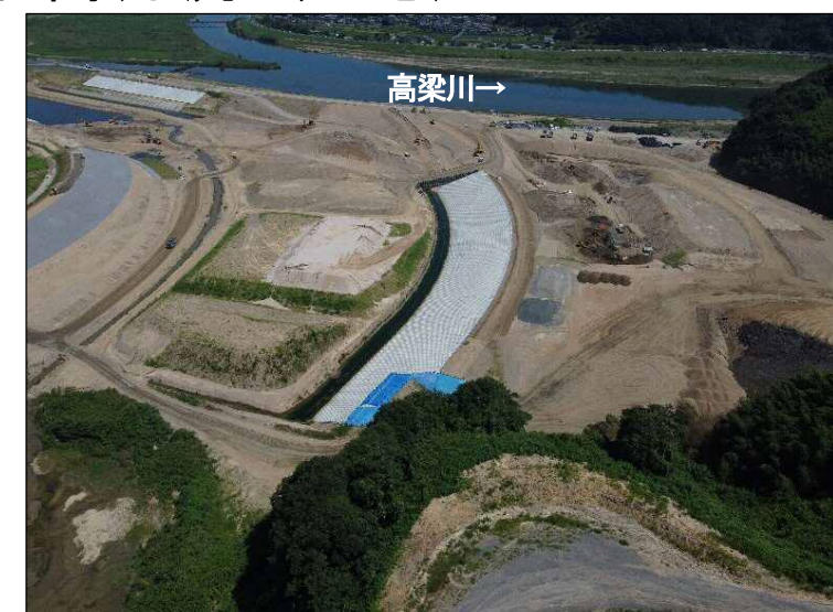
③掘削区間(下流より望む)
