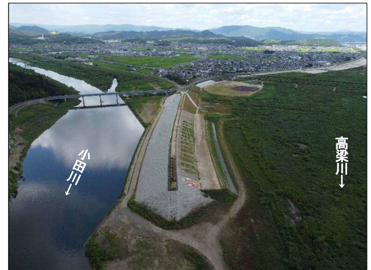
③締切区間(下流より望む)
