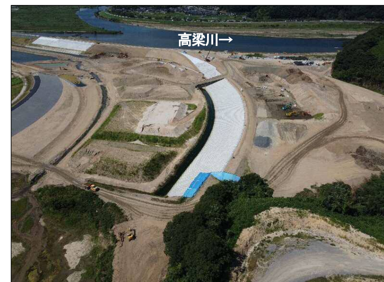
③掘削区間(下流より望む)
