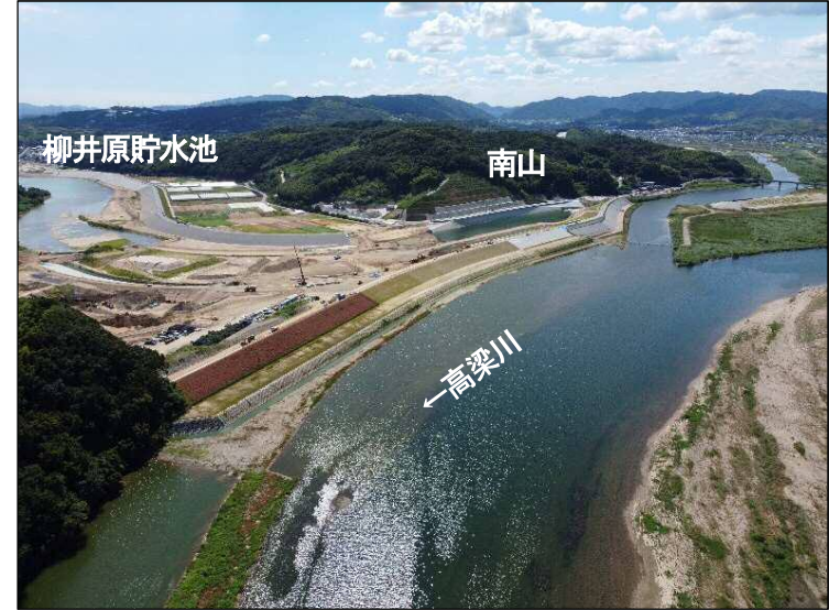
①締切区間(下流より望む)
