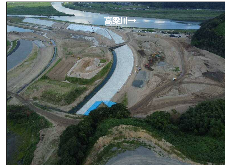
③掘削区間(下流より望む)
