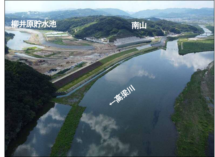
①締切区間(下流より望む)
