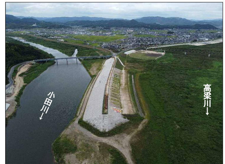
③締切区間(下流より望む)
