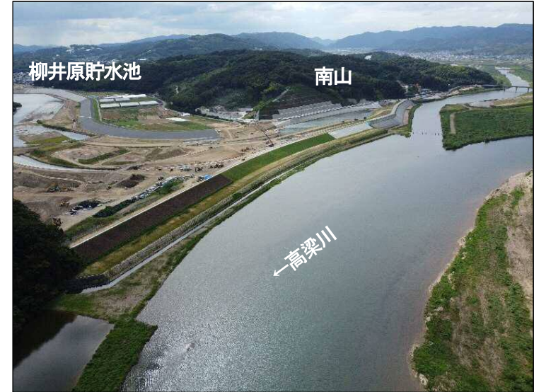
①締切区間(下流より望む)
