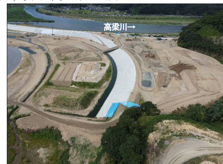
③掘削区間(下流より望む)
