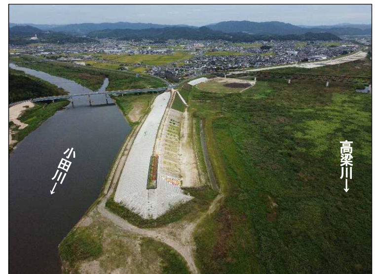
③締切区間(下流より望む)
