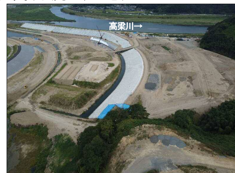
③掘削区間(下流より望む)
