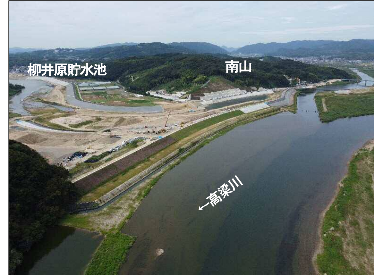
①締切区間(下流より望む)
