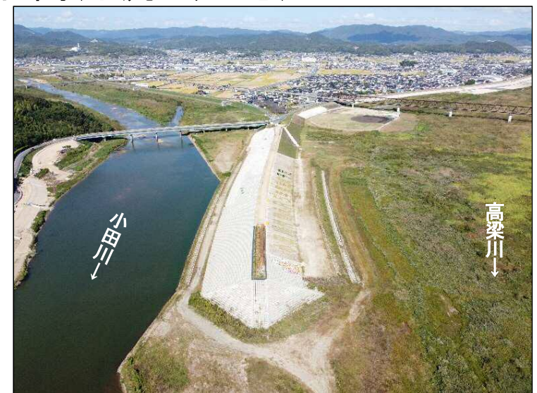
③締切区間(下流より望む)
