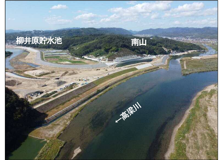
①締切区間(下流より望む)
