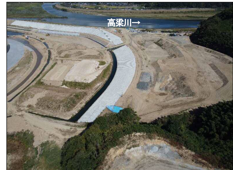
③掘削区間(下流より望む)
