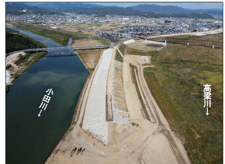
③締切区間(下流より望む)
