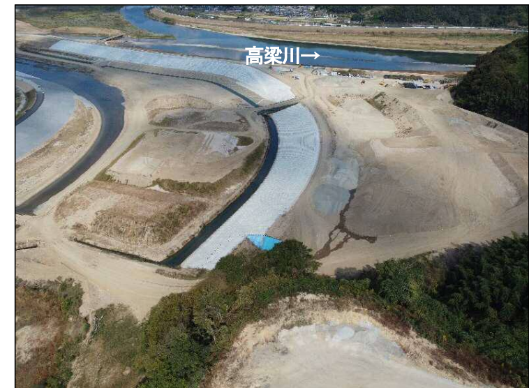
③掘削区間(下流より望む)
