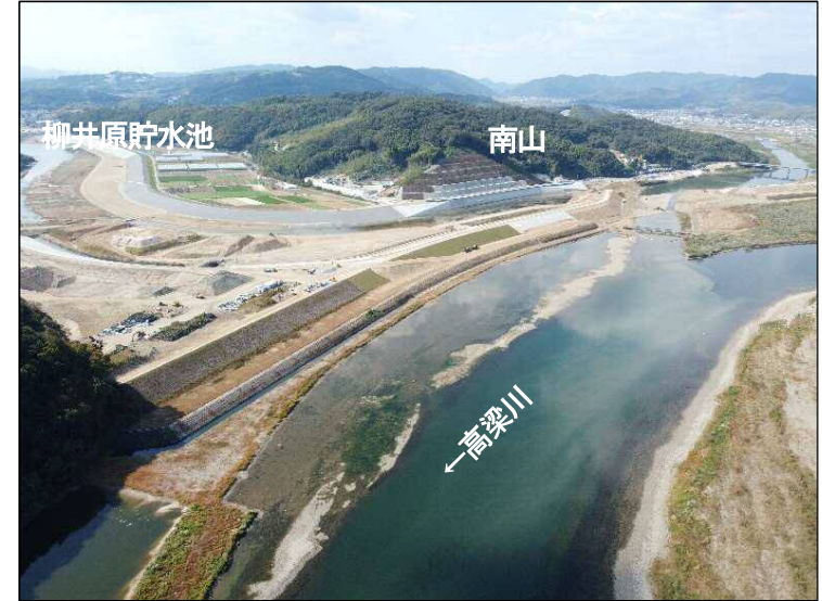
①締切区間(下流より望む)
