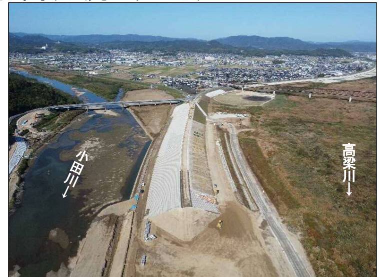
③締切区間(下流より望む)
