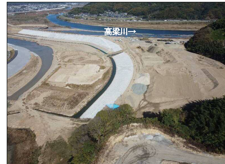
③掘削区間(下流より望む)
