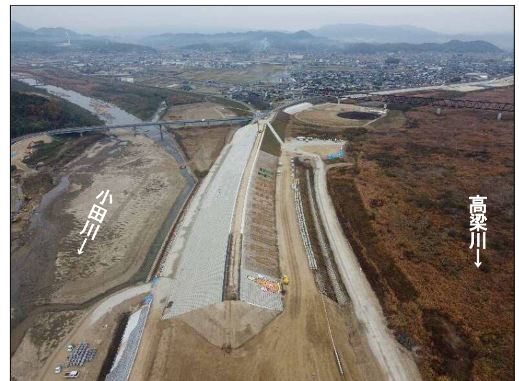
③締切区間(下流より望む)
