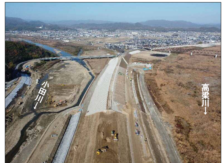
③締切区間(下流より望む)
