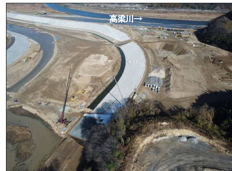
③掘削区間(下流より望む)
