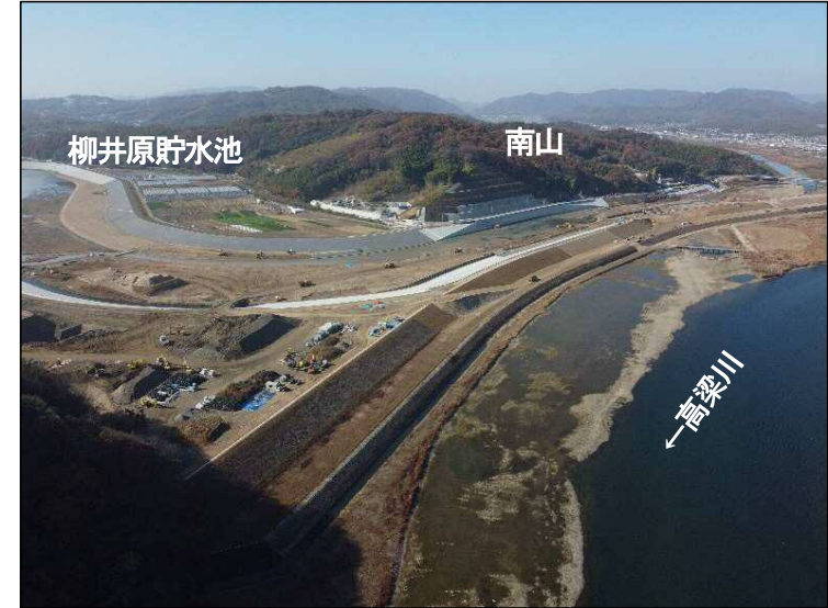
①締切区間(下流より望む)
