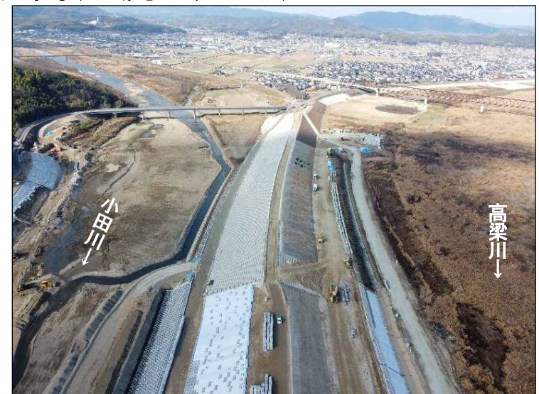
③締切区間(下流より望む)
