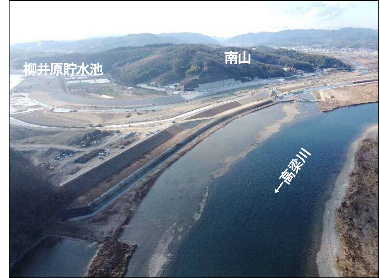
①締切区間(下流より望む)
