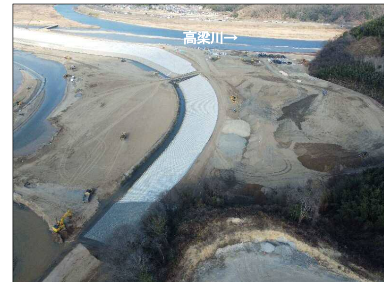
③掘削区間(下流より望む)
