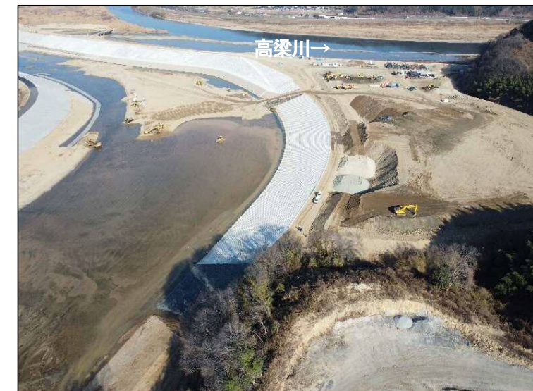
③掘削区間(下流より望む)
