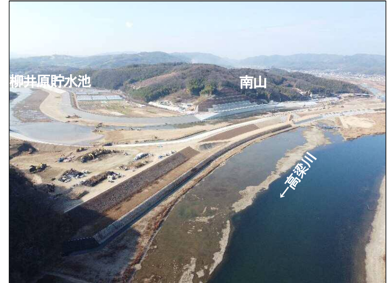
①締切区間(下流より望む)
