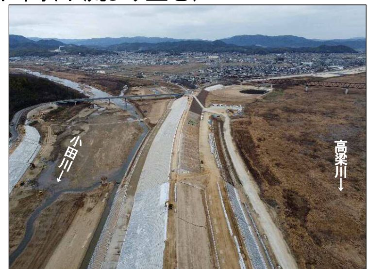
③締切区間(下流より望む)
