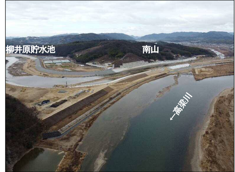
①締切区間(下流より望む)
