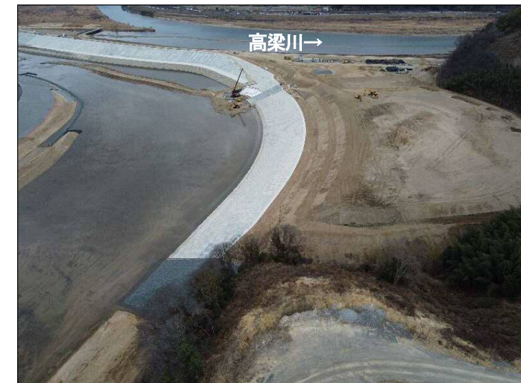
③掘削区間(下流より望む)
