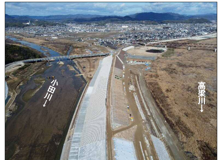
③締切区間(下流より望む)
