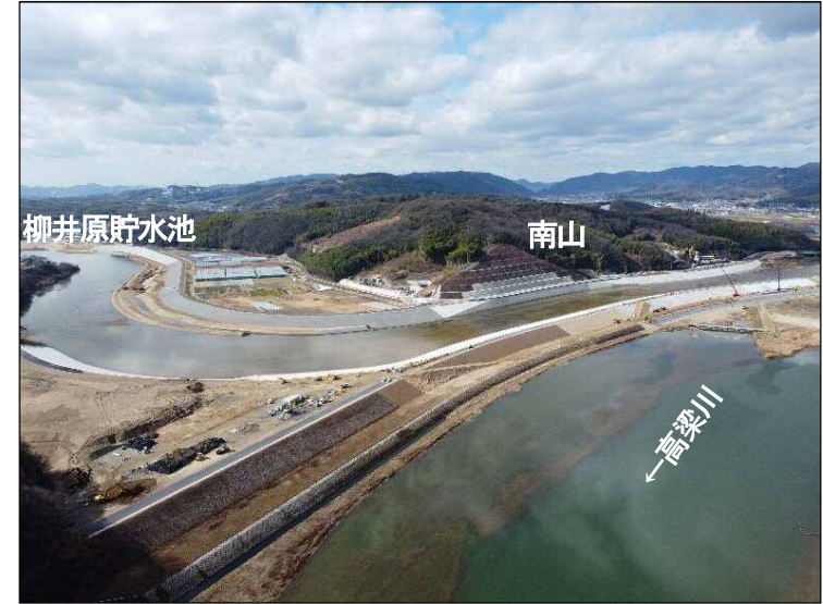
①締切区間(下流より望む)
