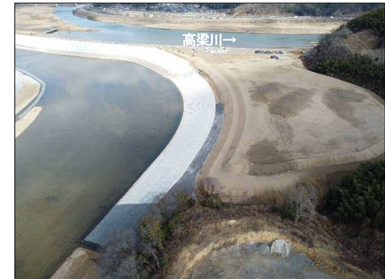
③掘削区間(下流より望む)
