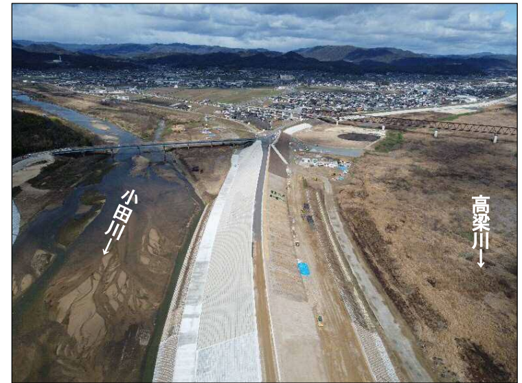
③締切区間(下流より望む)
