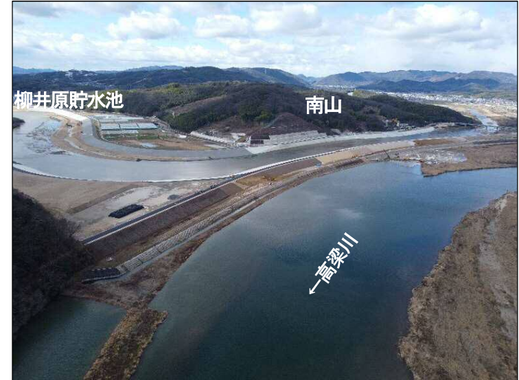
①締切区間(下流より望む)
