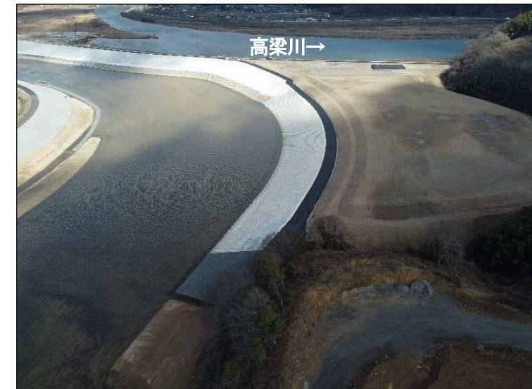
③掘削区間(下流より望む)
