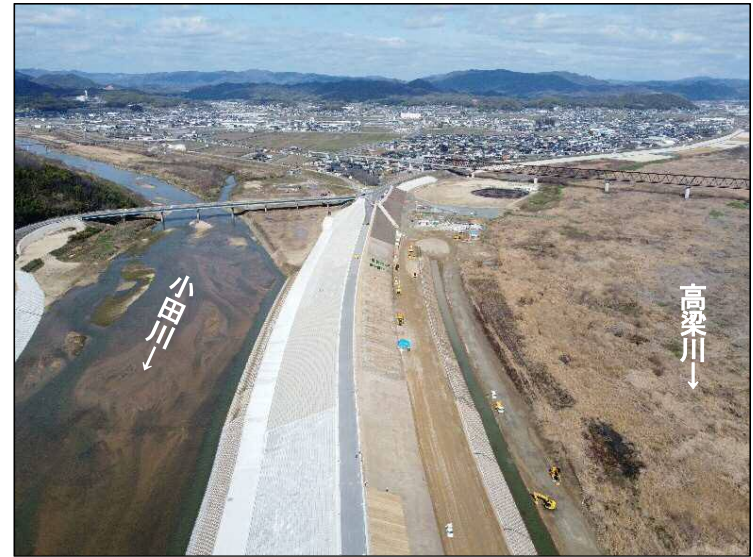
③締切区間(下流より望む)
