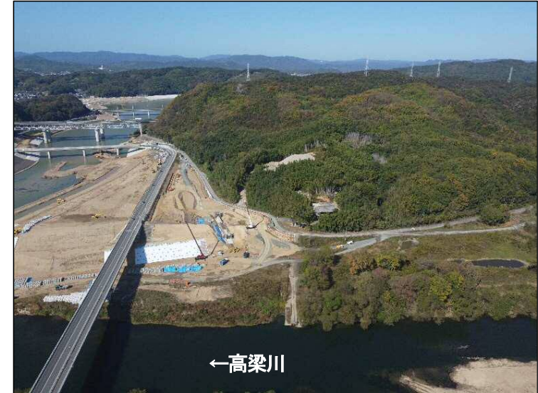
①護岸施工区間(下流より望む)
