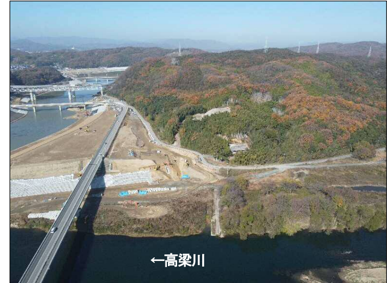
①護岸施工区間(下流より望む)
