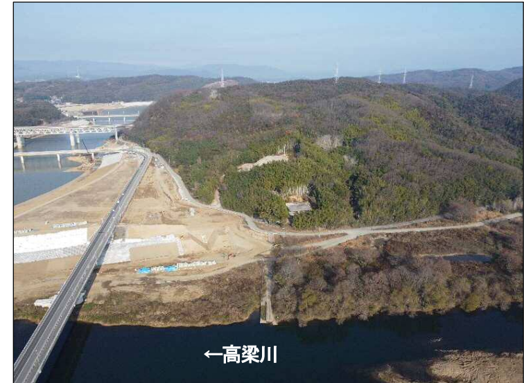
①護岸施工区間(下流より望む)
