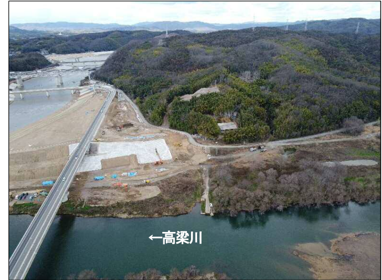
①護岸施工区間(下流より望む)
