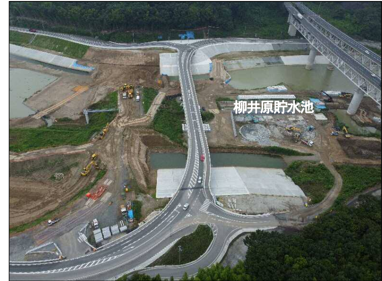
①掘削区間(左岸より望む)
