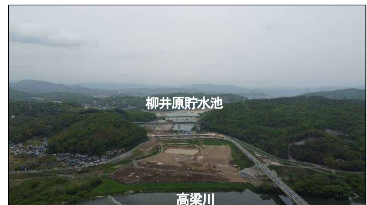
②掘削区間(下流より望む)
