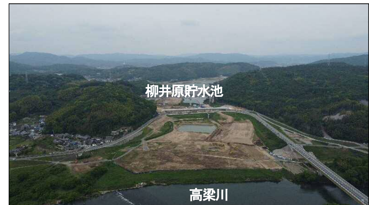
②掘削区間(下流より望む)
