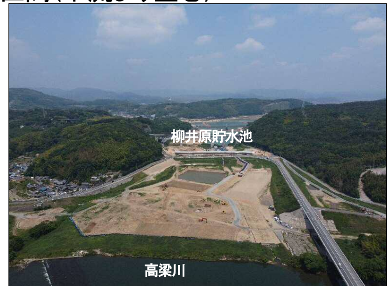
②掘削区間(下流より望む)
