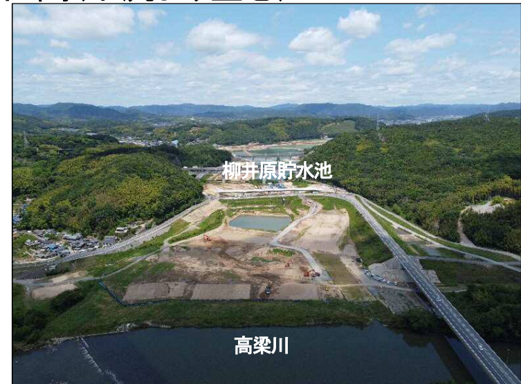
②掘削区間(下流より望む)
