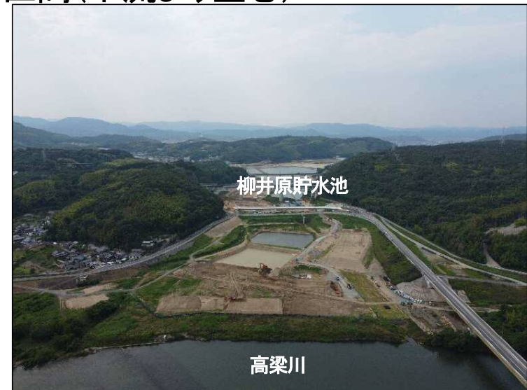
②掘削区間(下流より望む)
