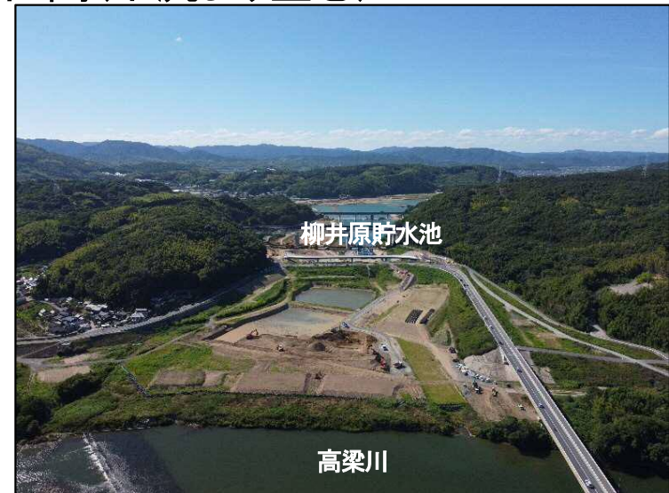
②掘削区間(下流より望む)
