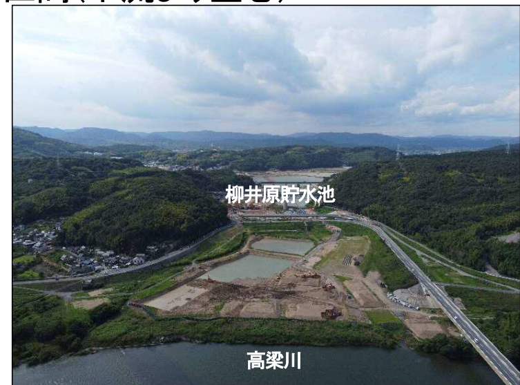
②掘削区間(下流より望む)
