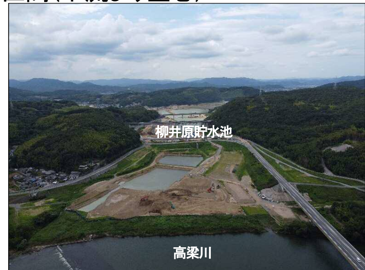
②掘削区間(下流より望む)
