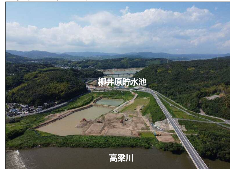
②掘削区間(下流より望む)
