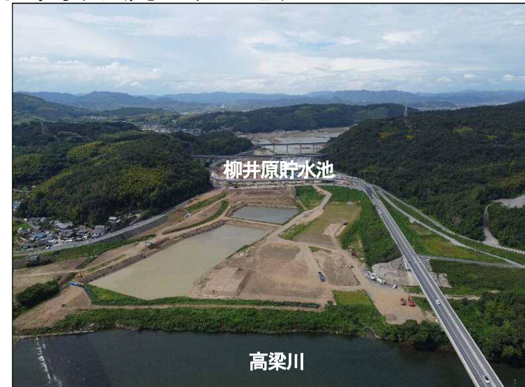
②掘削区間(下流より望む)
