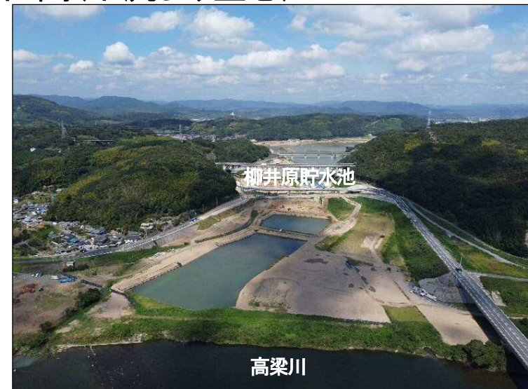
②掘削区間(下流より望む)
